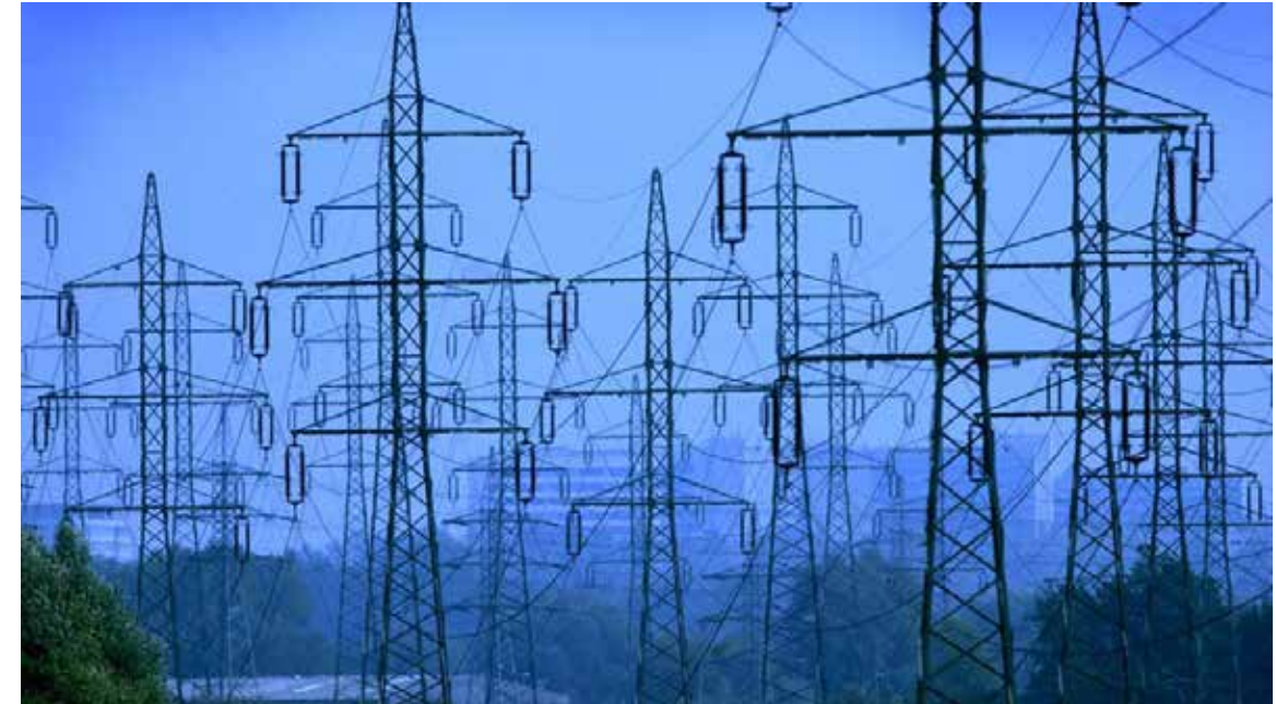
Problembereich II Energieverteilung
